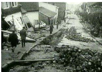
:: Daños en Valdivia.
