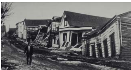
:: Daños en Valdivia.
