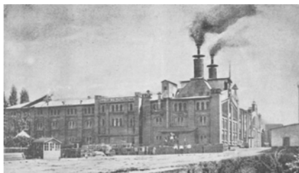
:: Fachada principal de la Fábrica de Cerveza de Carlos Cousiño, Providencia, Santiago, 1902.
